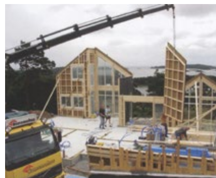
Montering av veggелеmenter på byggeplassen.
