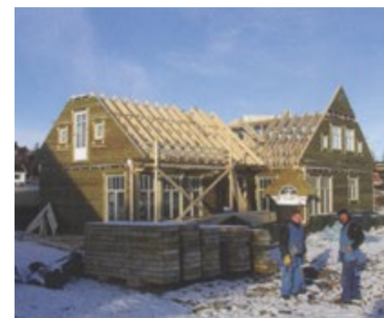
Taket legges etter at veggene er montert.
