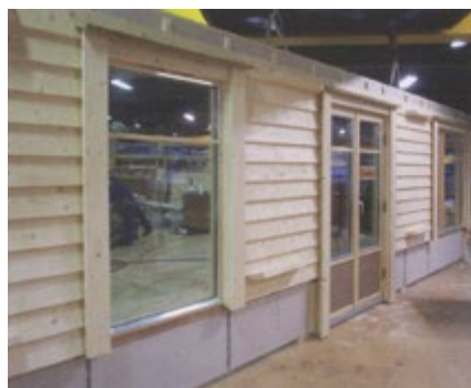
Ferdig element før transport.
