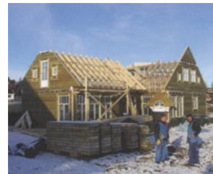
Taket legges etter at veggene er montert.
