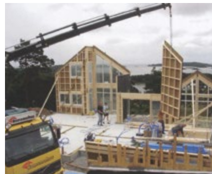
Montering av veggелеmenter på byggeplassen.
